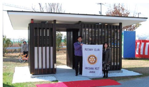
新築時のトイレ全景
